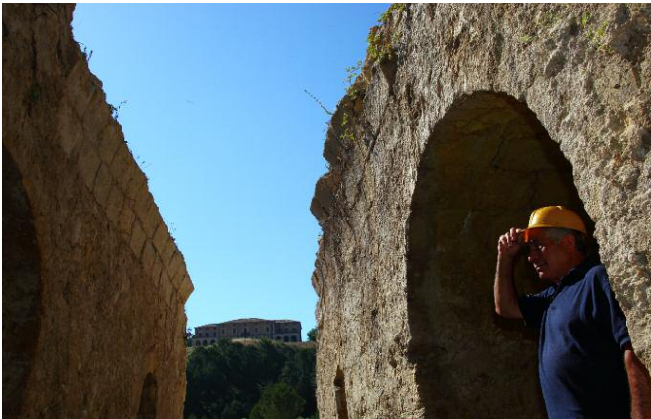
A fianco: I forni Gill che servivano a separare lo zolfo dal materiale grezzo. (Parco Minerario Floristella-Grottacalda)
