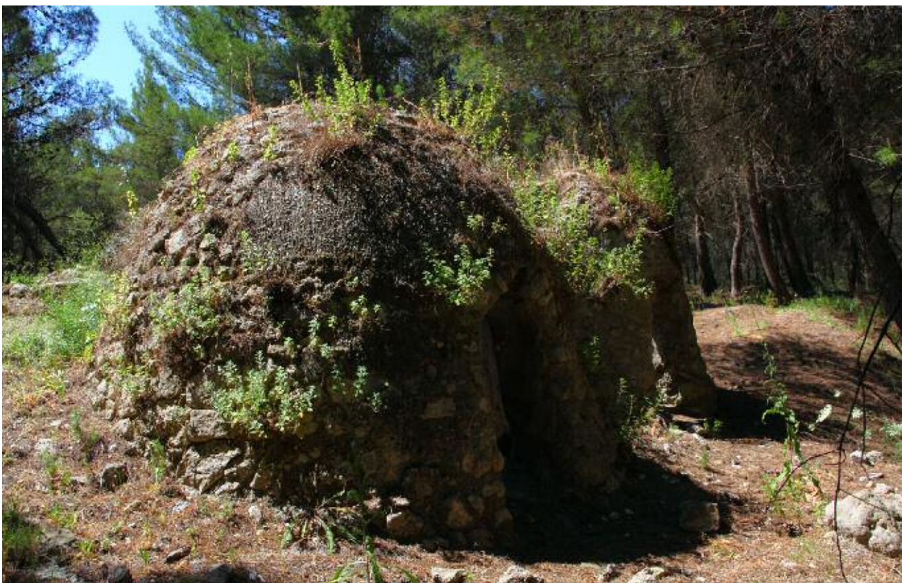
A fianco: Primi tentativi di sperimentazione dei forni Gill. (Parco Minerario Floristella-Grottacalda)
